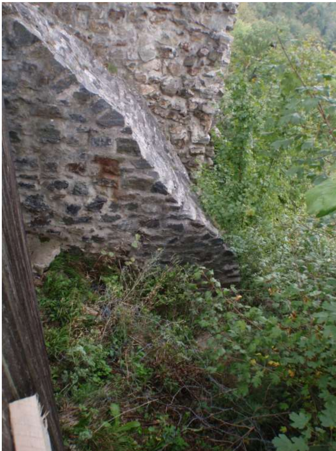
Pohled na hradební zdivo starého paláce, na které bude obnovovaná hradební stěna navazovat.
